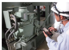
点検アプリを活用した作業風景
