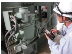
点検アプリを活用した作業風景
