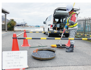
調査開始地点の作業風景
