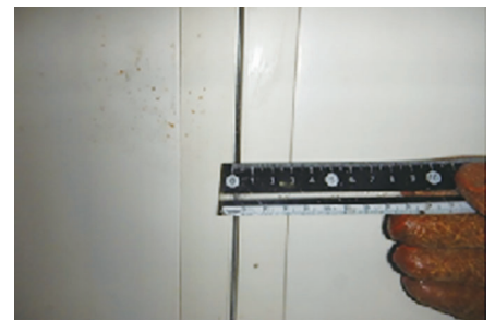
図-3 SFジョイナー目開き部(約5mm)
