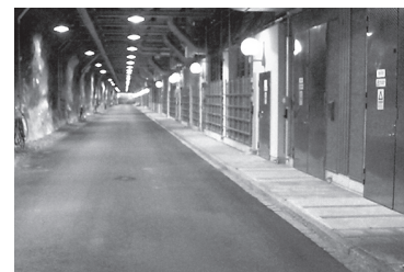
装飾が施された地下管廊
