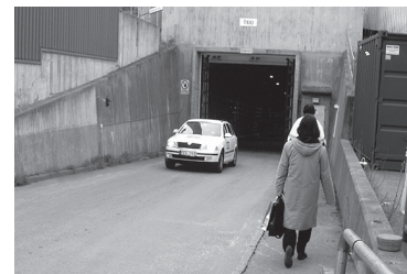
シェッパラ処理場の入口
