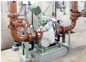
配管を接続したままで、内部の点検や、トラップに溜まった固形物の回収・除去を行えます。部品点数が少ないシンプルな構造なので、現場で、短時間で部品交換を完了できます。
